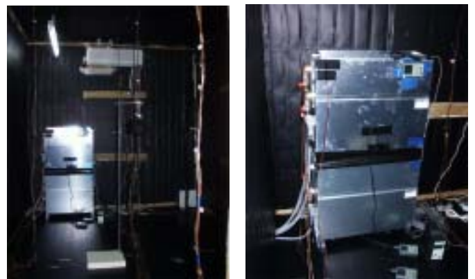
図13 放射制御環境試験室の様子と除湿・再熱用ファンコイルユニット
