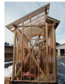
図 B棟東側外観
