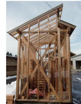
図 A棟東側外観
