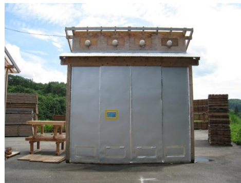
図 A棟北側外観
