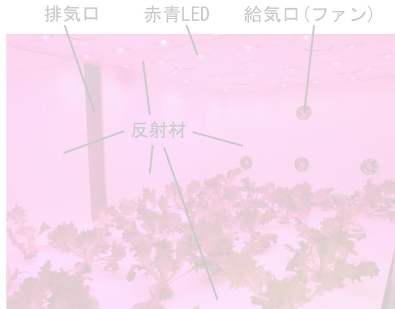
図4 光・空調制御ダクト型
